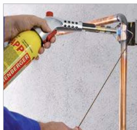
Пайка твердым припоем при монтаже системы газоснабжения
