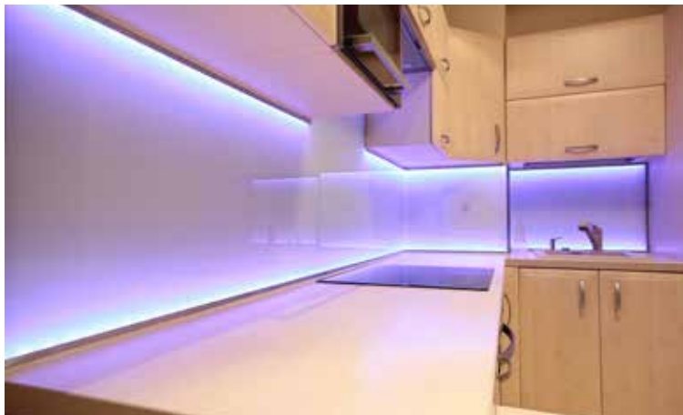
Лента 12 В 60 LED/м, SMD5050, 10 мм шаг резки 5 см
